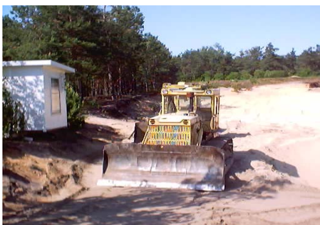
Rys 5. Prace ziemne związane z budową niecki nr I składowiska ZUOK w Ożarowie; czerwiec 2003r. Źródło: materiały własne
